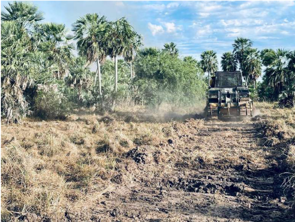
Maquinaria del Comando de Ingeniería realizando trabajos designados.
