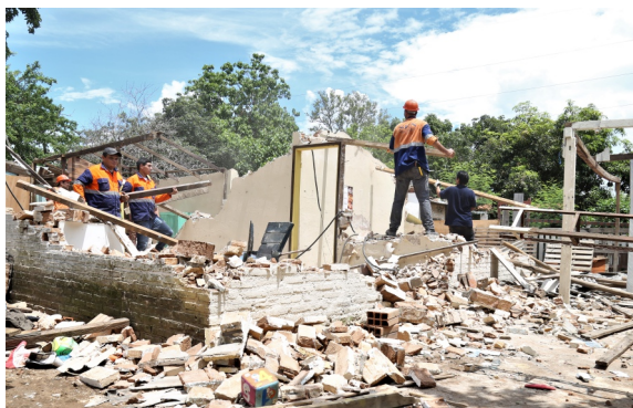
La SEN realizó, además, la demolición de las viviendas desocupadas en la zona vulnerable, a fin de evitar su reocupación.
