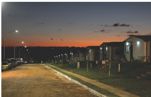
Un total de 222 familias se beneficiaron en 2015 con viviendas seguras en el barrio Las Colinas, lejos de múltiples amenazas.
